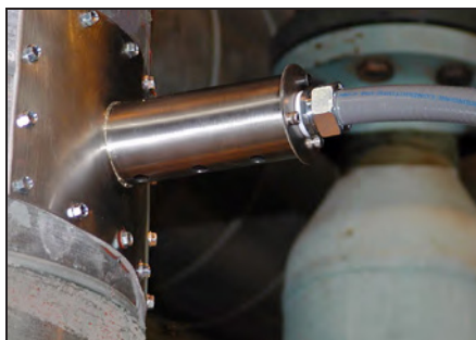
Figura 2-7 CB02-ICSA Montado en el tiro
